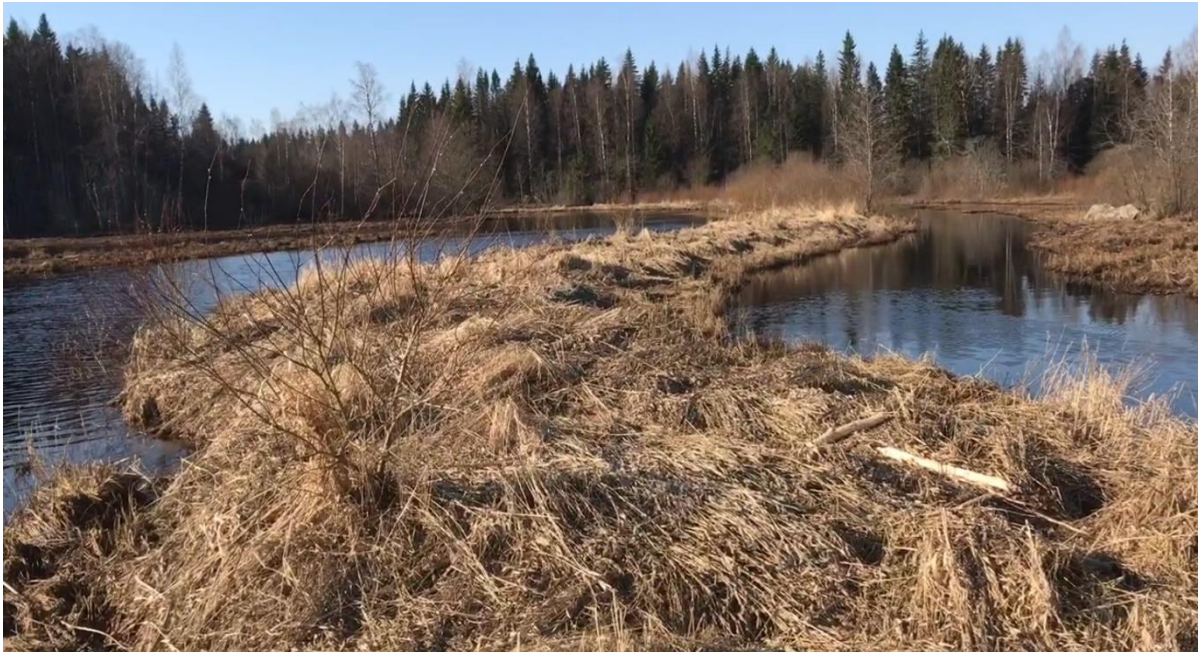
Kuva 2-3. Takalampinniitun reunapenger kuvattuna 9.3.2020 kevättulvan aikaan. Vesipinta on sama penkereen molemmin puolin. Penkereen oikealla puolen on Poosjoki ja vasemmalla puolen on Takalampinniitun kuivatusuoma.
